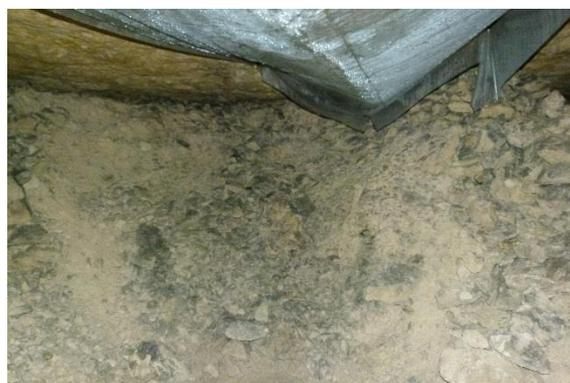
L'extraction souterraine de la pierre de taille se faisait en profitant des différences de compacité entre les différentes couches horizontales. Le front de taille était ainsi attaqué en réalisant une entaille horizontale, profonde de 1m, dans le lit tendre séparant les 2 niveaux véritablement exploités.
